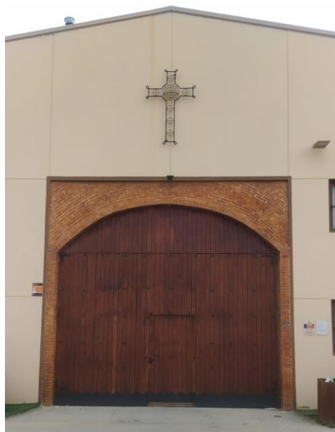
Fachada de la iglesia ortodoxa de Albacete. Fuente : foto realizada por las investigadoras.
